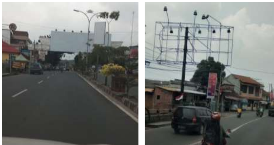
Gambar 3.8 Pemeriksaan Tempat Pemasangan
