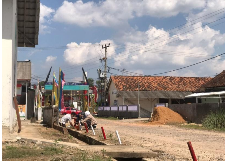
Gambar 2.3 Gotong Royong Memasang Patok Di Pinggir Jalan Desa Adirejo
