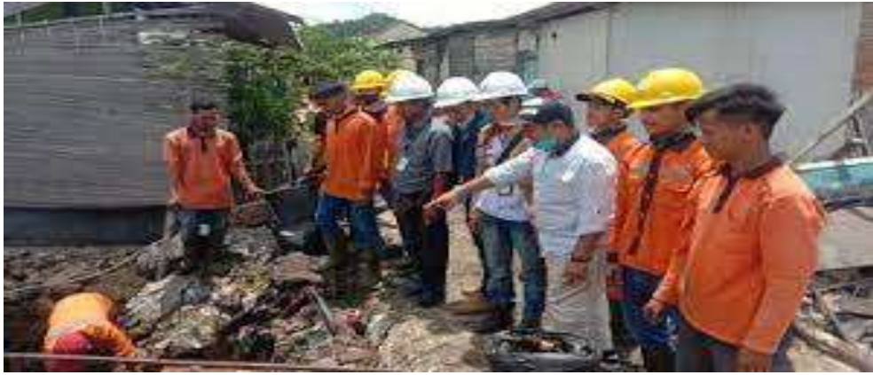
Gambar 1.2 Pekerja Outsourcing melakukan perbaikan
