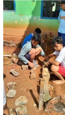
Gotong royong membangun teras balai desa sumber jaya
