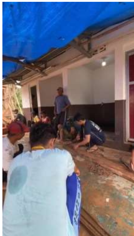
Gambar 2.11 Membantu proses pembuatan rangka bangunan
