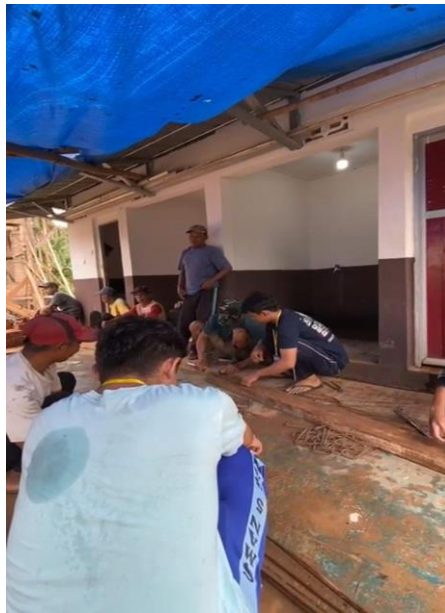
Gambar 2.14 Membantu proses pembuatan rangka bangunan
