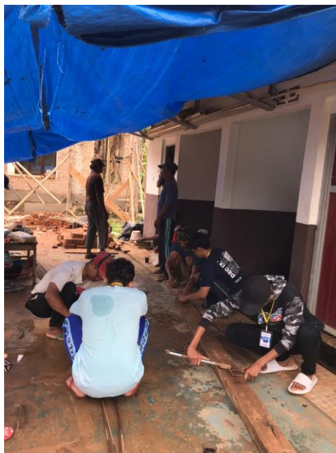
Gambar 2.12 Membantu proses pembuatan rangka bangunan
