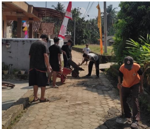
Membantu Memperbaiki Jalan di Dusun Warna Sari
