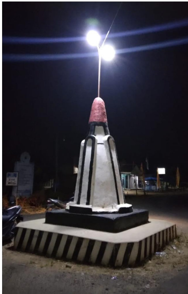
Gambar 2.23 Pemasangan Penerangan Lampu Tugu
