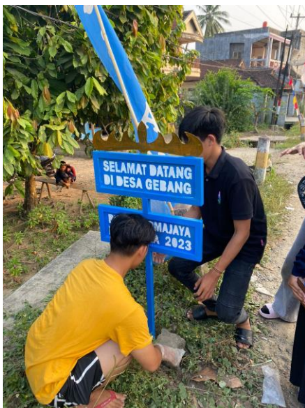
Gambar 4.8 Pemasangan Plang Nama
