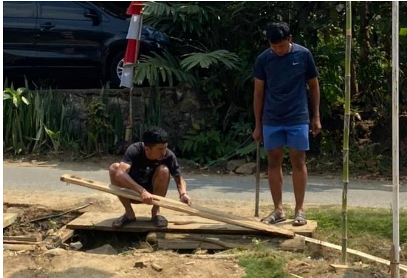
Gambar 25 Memperbaiki jembatan di rumah kepala dusun
