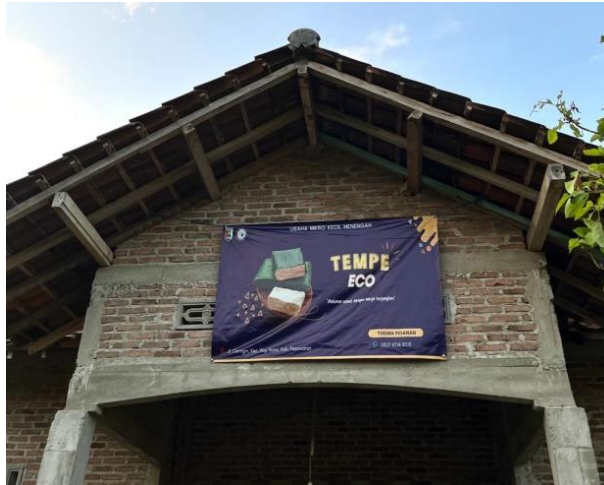
Gambar 2.19 Pemasangan banner di UMKM Tempe Eco
