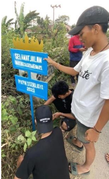
Pemasangan Plang Perbatasan Desa
