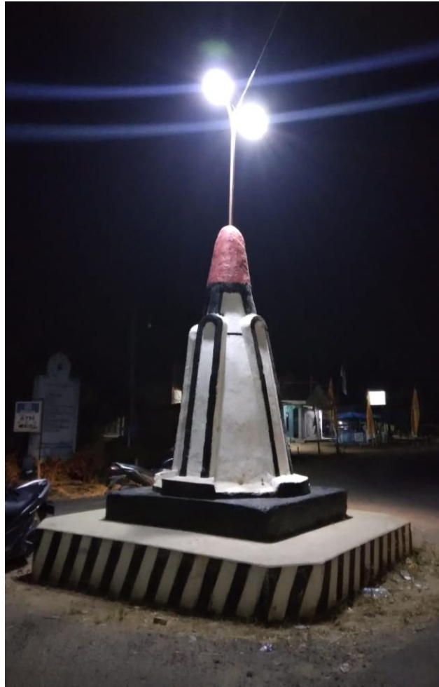
Gambar 2.23 Pemasangan Penerangan Lampu Tugu
