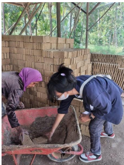
Gambar 11 Penyusunan Tobong Bata
