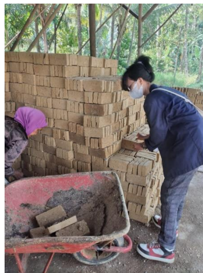
Gambar 11 Penyusunan Tobong Bata
