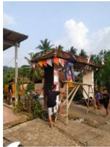
Gambar 18: Pengecatan Gapura Dusun Umbul Rejo
