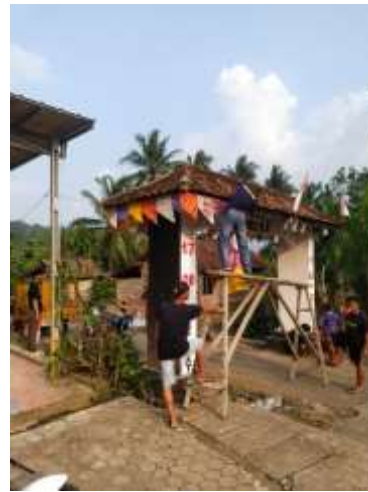
Gambar 10: Pengecatan Gapura Dusun Umbul Rejo
