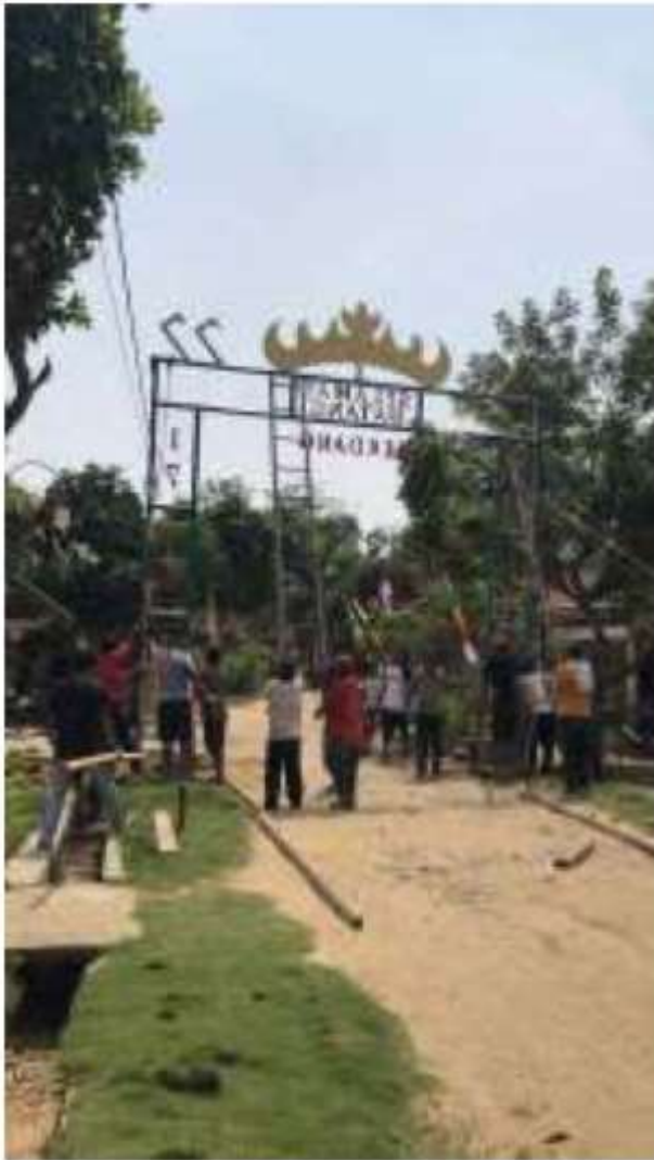
Gotong Royong Pembuatan Gapura Di Dusun Karang Indah
