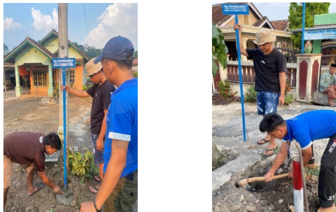
Gambar 2.3.2.6 Pemasangan Sign Sistem atau Nama Plang Jalan.
