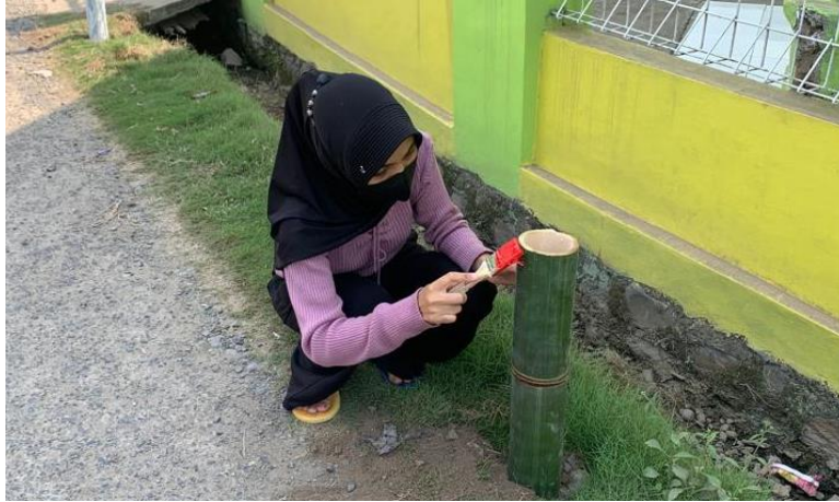
Pengecetan rambu jalan di Desa Kampung Baru
