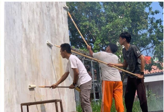
Proses pengecatan untuk persiapan Nobar dan Bazar UMKM
