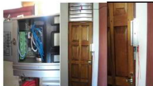
Gambar 8 Magnetic lock pada pintu
