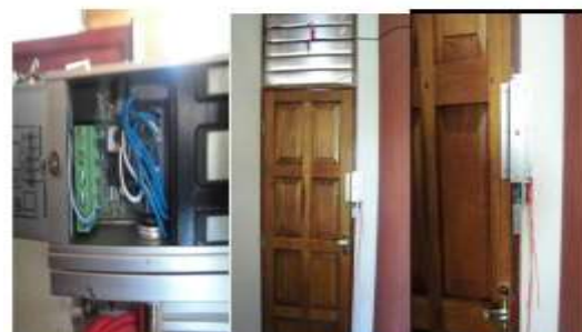
Gambar 8 Magnetic lock pada pintu
