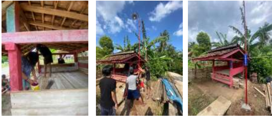
Gambar 14 Renovasi Pos Ronda dan Pemasangan Lampu Jalan
