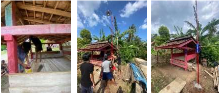
Gambar 14 Renovasi Pos Ronda dan Pemasangan Lampu Jalan
