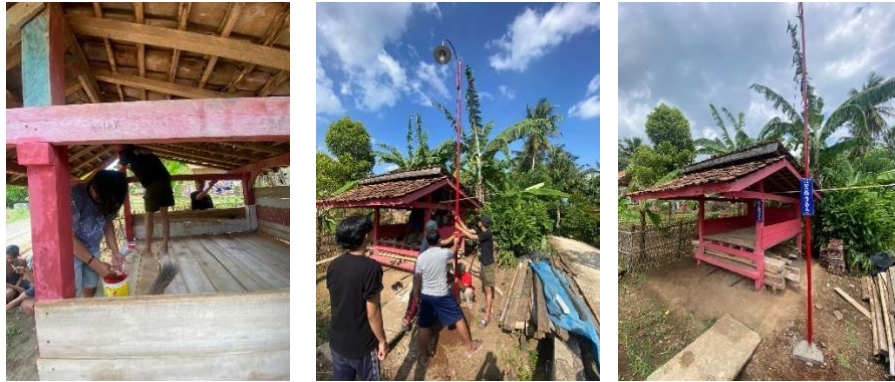
Gambar 14 Renovasi Pos Ronda dan Pemasangan Lampu Jalan
