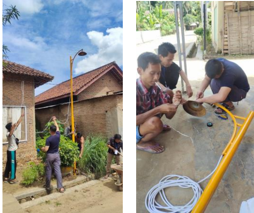
Gambar 2. 14 Memasang Tiang Lampu Jalan
