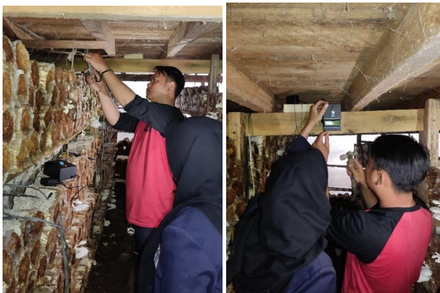
Gambar 2. 7 Pemasangan alat suhu dan kelembapan
