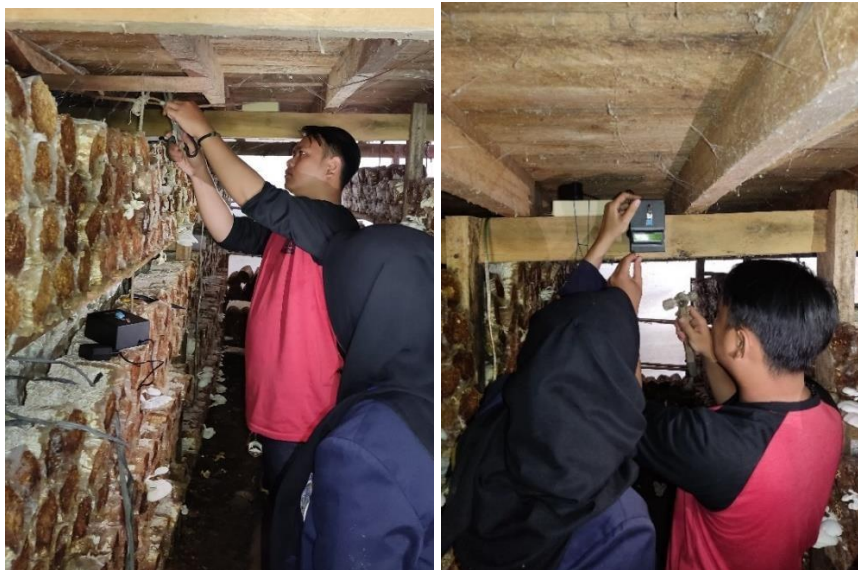
Gambar 2. 9 Pemasangan alat suhu dan kelembapan
