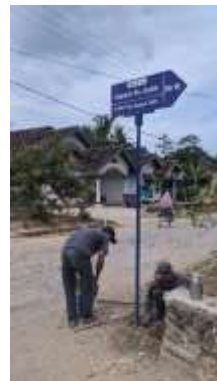
Gambar 2. 51 Pemasangan papan penunjuk arah
