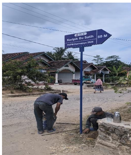
Gambar 2.7 Pemasangan plang UMKM
