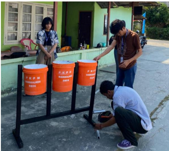
Pembuatan Bak Sampah untuk Bank Sampah Kel. Metro
