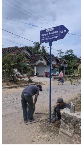
Gambar 2. 39 Pemasangan Papan Penunjuk Arah
