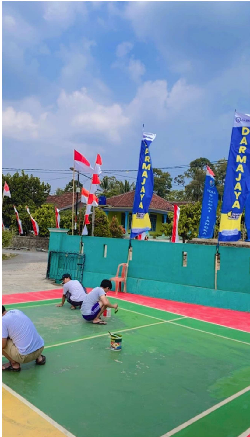
Gambar 2.19 Pengecatan ulang lapangan bulutangkis
