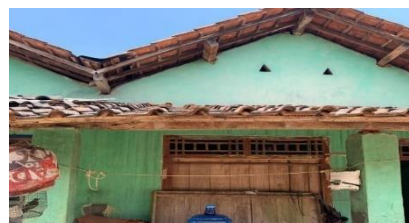
Gambar 2.10 Sebelum pemasangan Banner
