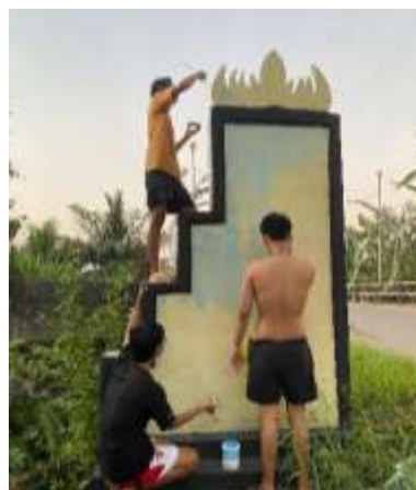
Pengecatan Gapura Selamat Datang Summersari Bantul.
