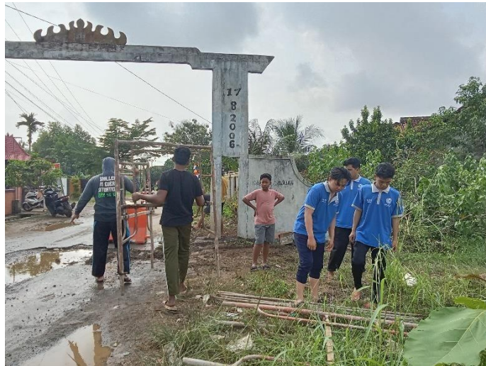
Gotong royong perbaikan gapura RW 01
