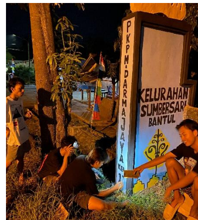
Pengecatan Gapura Selamat Datang Sumbersari Bantul.
