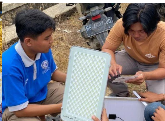
Memasang lampu penerangan jalan di desa Kedondong
