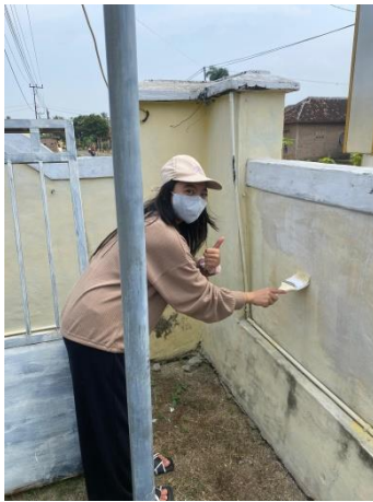
mengecat balai desa kedondong
