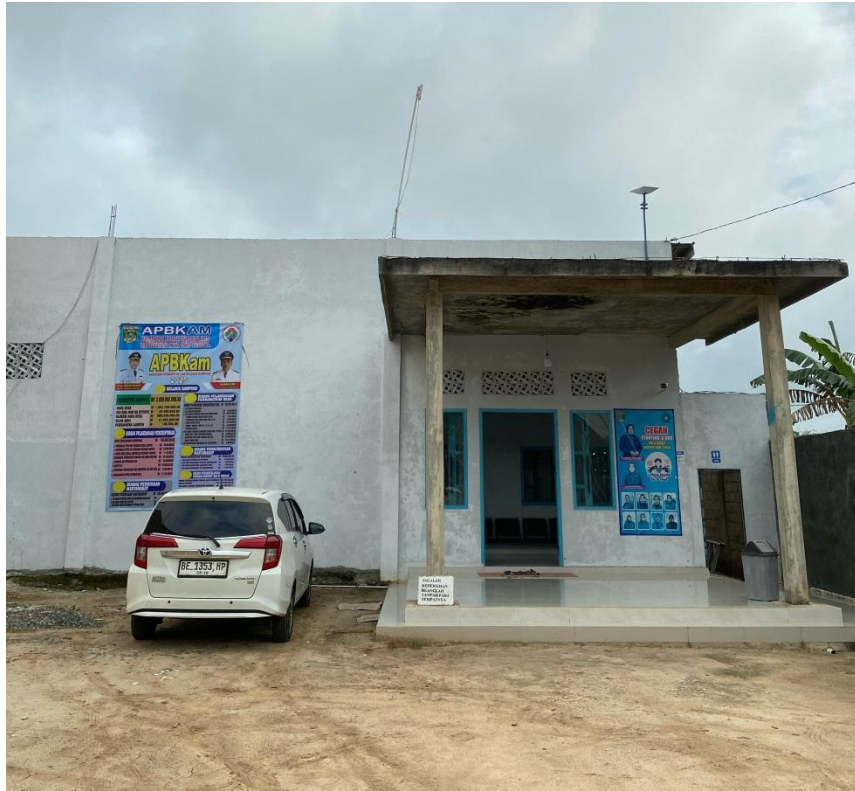
Tampak depan Kantor Kampung Tanjung Ratu Ilir
