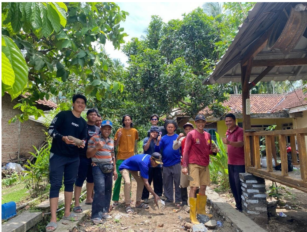
Gambar 2.16 Gotong Royong Membuat Pondasi Jalan
