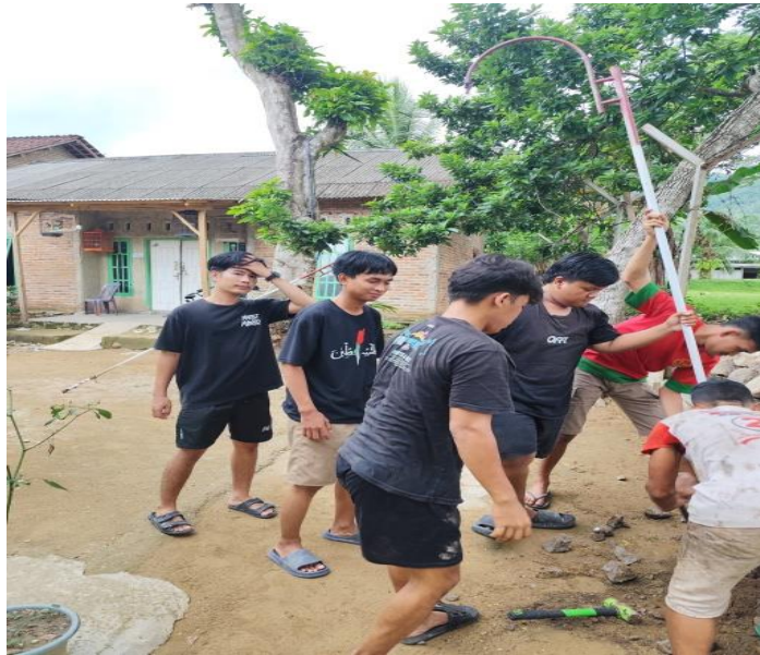
Gambar 2. 12 Pemasangan Lampu jalan
