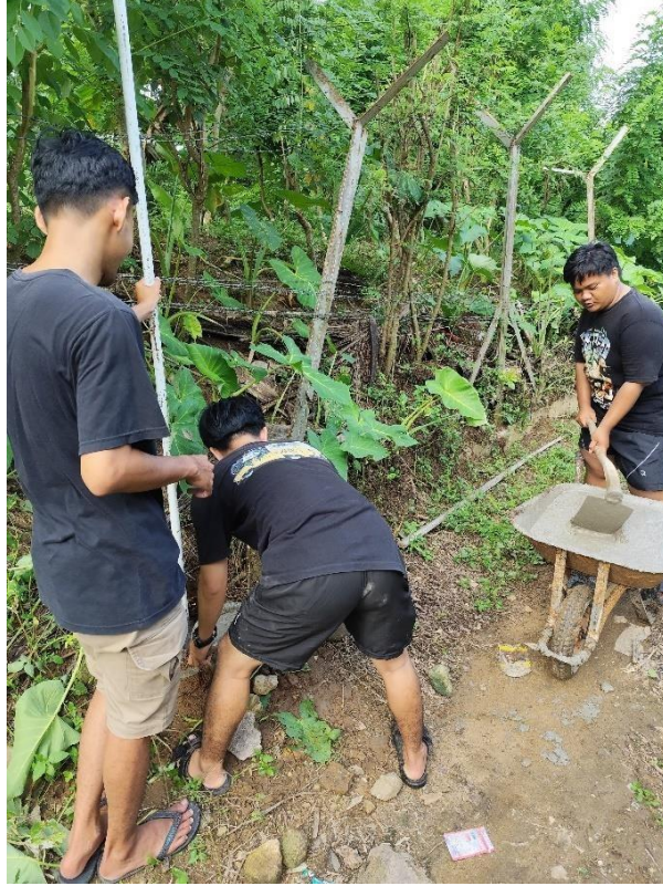
Gambar 2. 10 Pemasangan Lampu Jalan bertenaga surya
