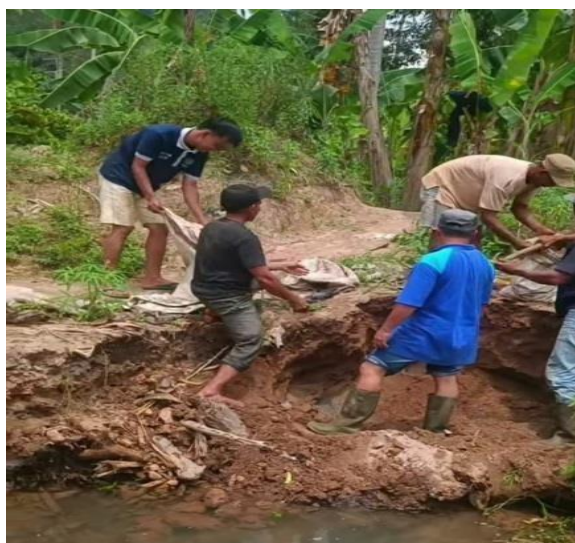
Gambar 2.7 Gotong Royong pembuatan jembatan bersama warga dusun desa dantar 1
