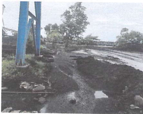
Gambar 4.3 Kondisi Area Operasional
