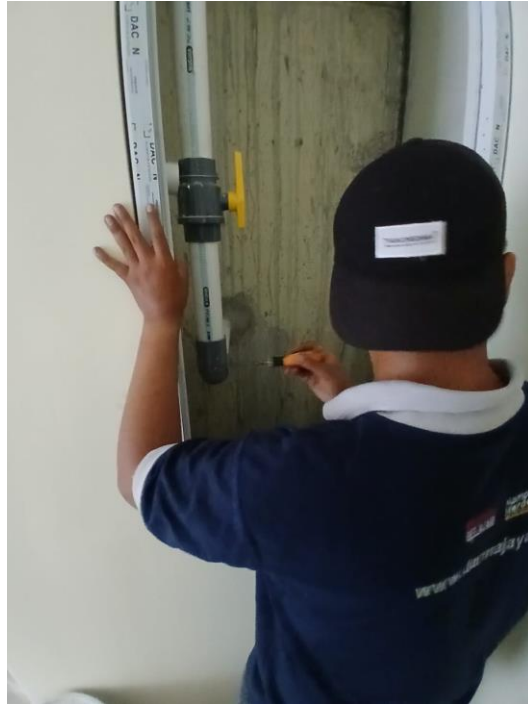
Gambar 1 Pemasangan pintu Kontraktor Listrik di Rumah Sakit Graha Husada
