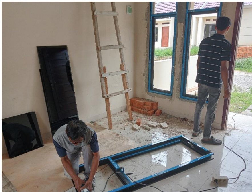
Gambar 2. Perakitan dan Pemasangan Jendela dan Pintu di Perumahan Beringin Raya
