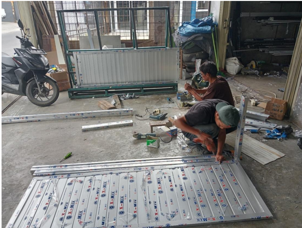
Gambar 5. Perakitan Pintu untuk di Rumah Sakit Bumi Waras
