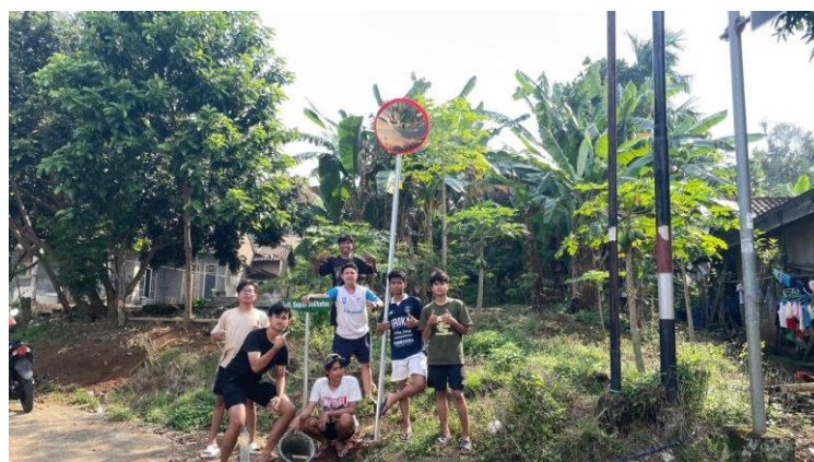
Gambar 24 Pemasangan Cermin Cembung
