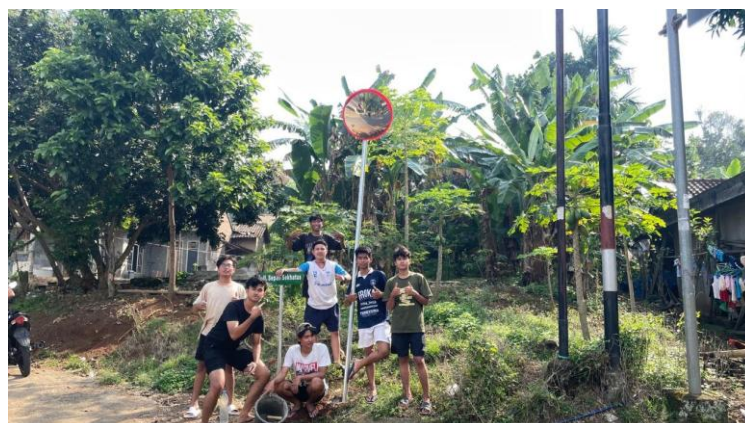
Gambar 25 Pemasangan Cermin Cembung
