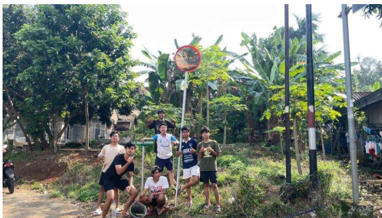
Gambar 25 Pemasangan Cermin Cembung
