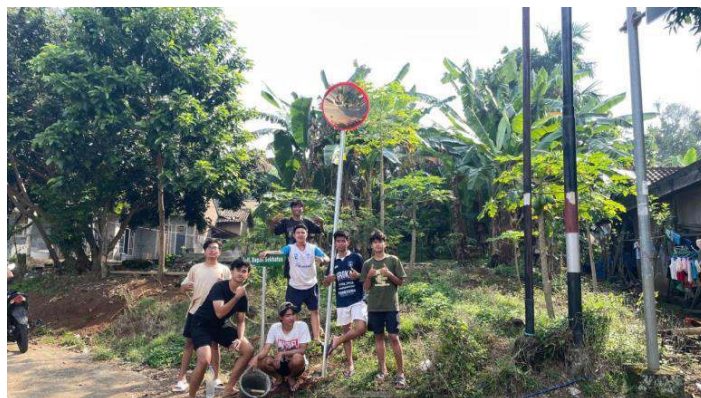
Gambar 25 Pemasangan Cermin Cembung
